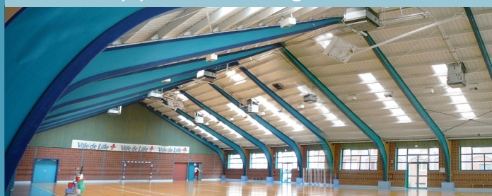
Site équipé en lampes iodure + système HORUS
